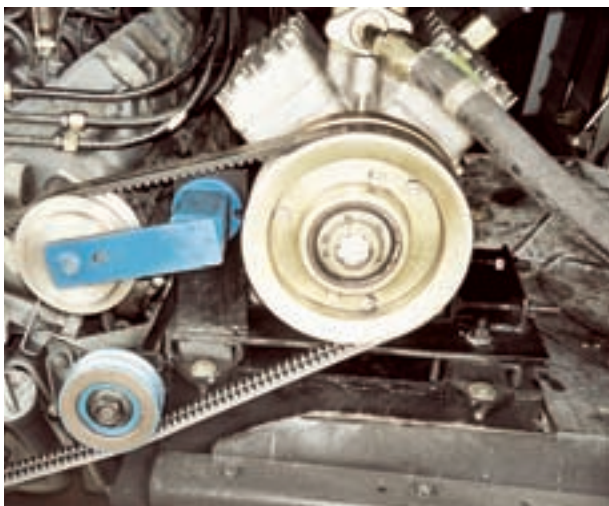
Riemenspanner an Kältekompressor in Bus
